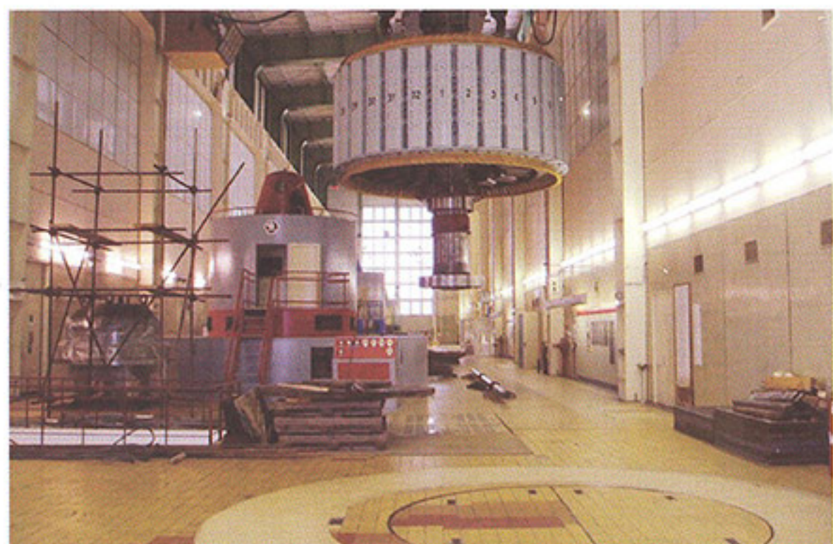
Přeprava rotoru generátoru
